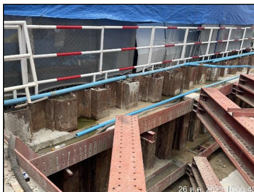
ภาพที่ 81 Sheet Pile และ เหล็กค้ำยัน
