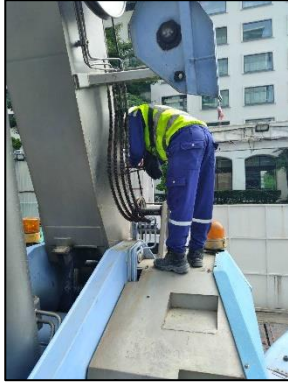
ภาพที่ 61 ตรวจสอบระบบเบรก Limit Switch สลิง เชือก
