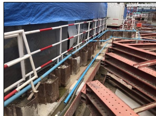
ภาพที่ 81 Sheet Pile และ เหล็กค้ำยัน
